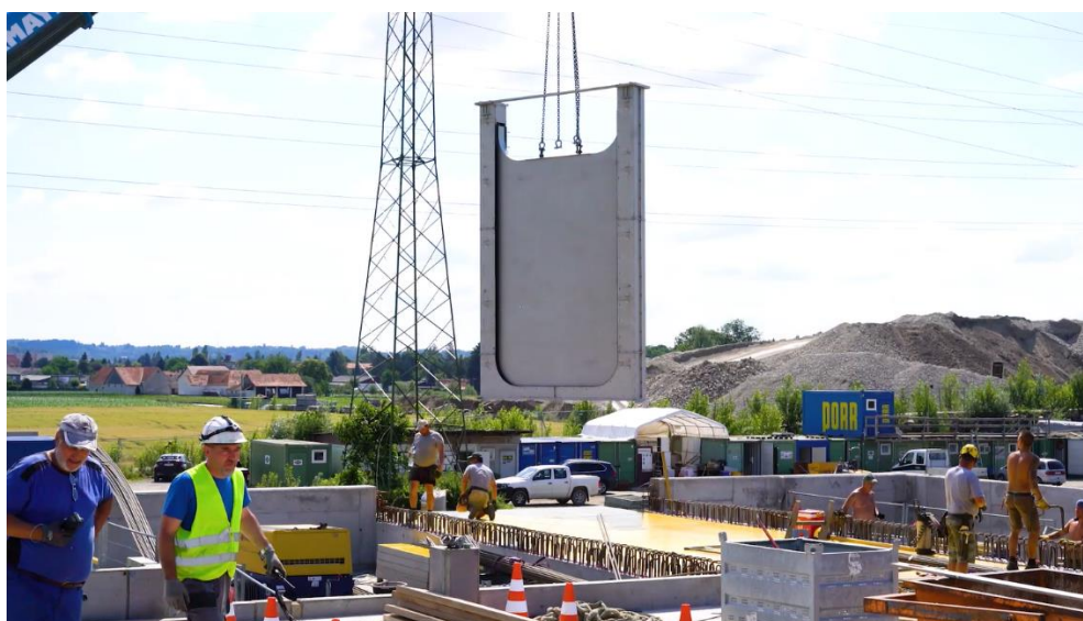
Das Versetzen der Hubwehre erfordert einige Vorbereitungsarbeiten.
