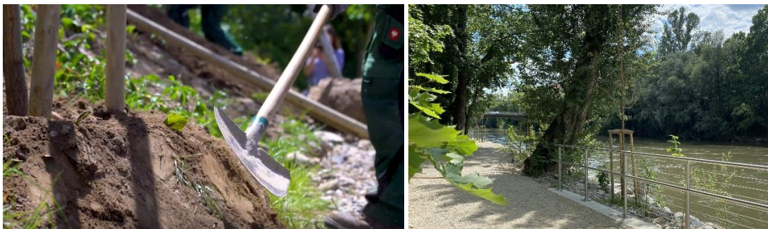
Die Promenade südlich der Radetzkybrücke wurde mittlerweile freigegeben.
