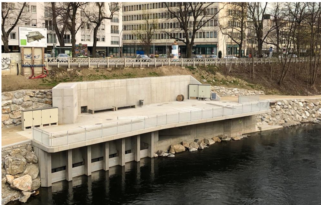
Kaskadenbauwerk südlich der Radetzkybrücke | April 2020
